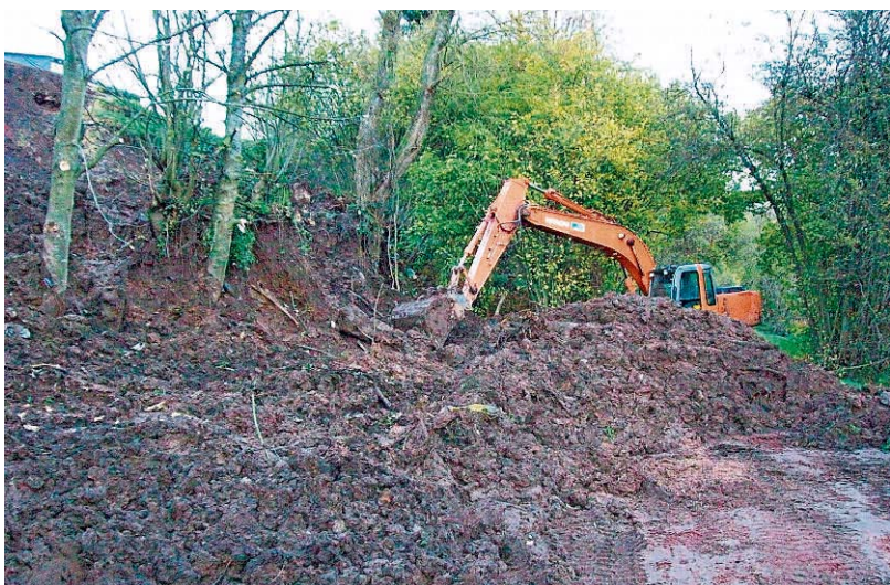
Ein Erdbeben verschüttete den Radweg bei Lockweiler. FOTO: STADT
